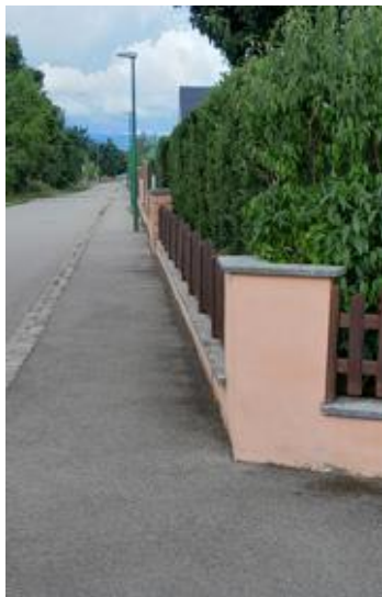
Haie bien entretenue et conforme
