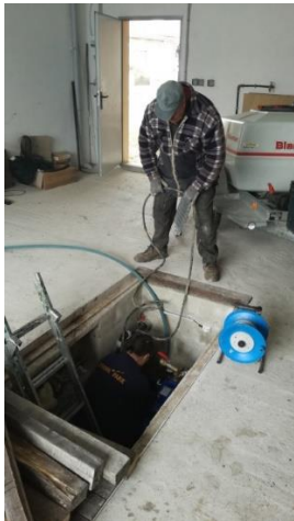
Dessablage du puit de la pompe aux Ateliers Municipaux
