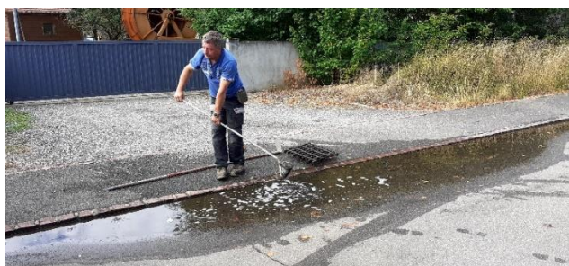
Débouchage des avaloirs
